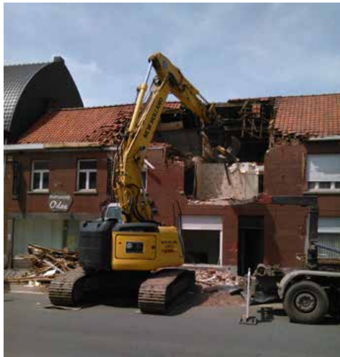
Huizen in afbraak maken plaats voor nieuwbouw (eigen opname).
